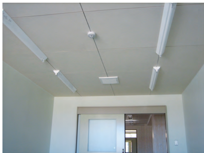
小学校図書室書庫 (天井)
